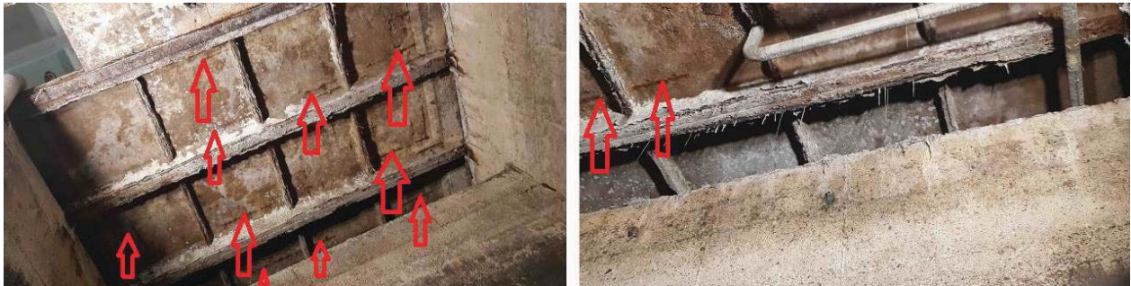
22,23 pav. Korozijos pažeista G/B perdanga
