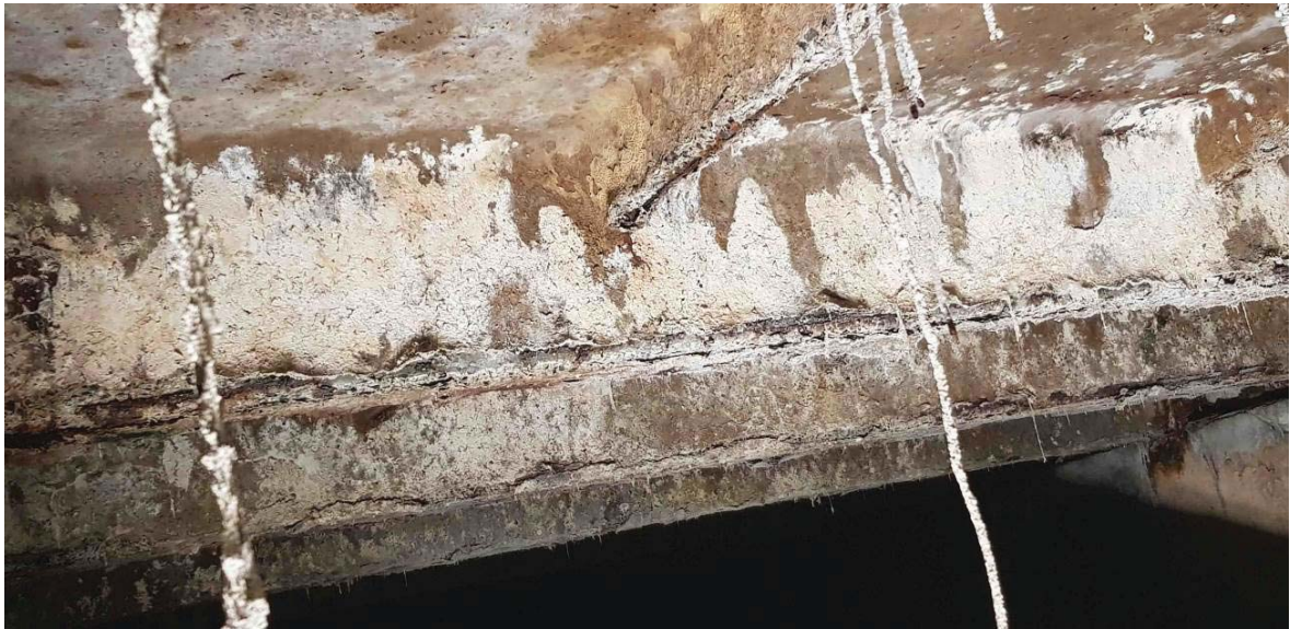
21 pav. Korozijos pažeista G/B perdanga
