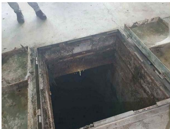
11,12 pav. Metalinių sijų korozija ties anga
