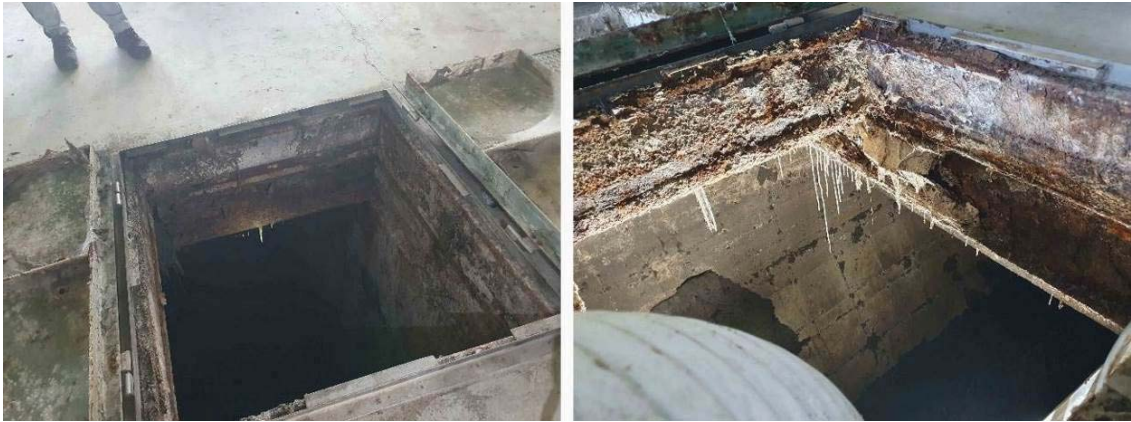
14,15 pav. Metalinių sijų korozija ties anga
