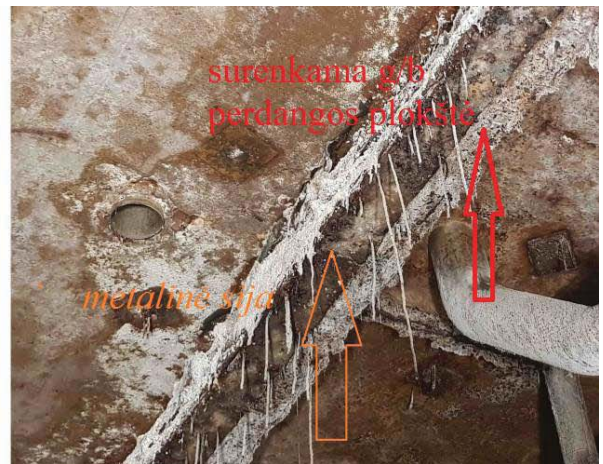
19,20 pav. Dvitėjinės metalinės sijos ir perdangos detalė
