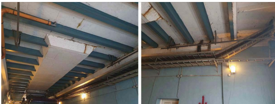
5,6 pav. Bunkerio dugno plokštės pažaidos
