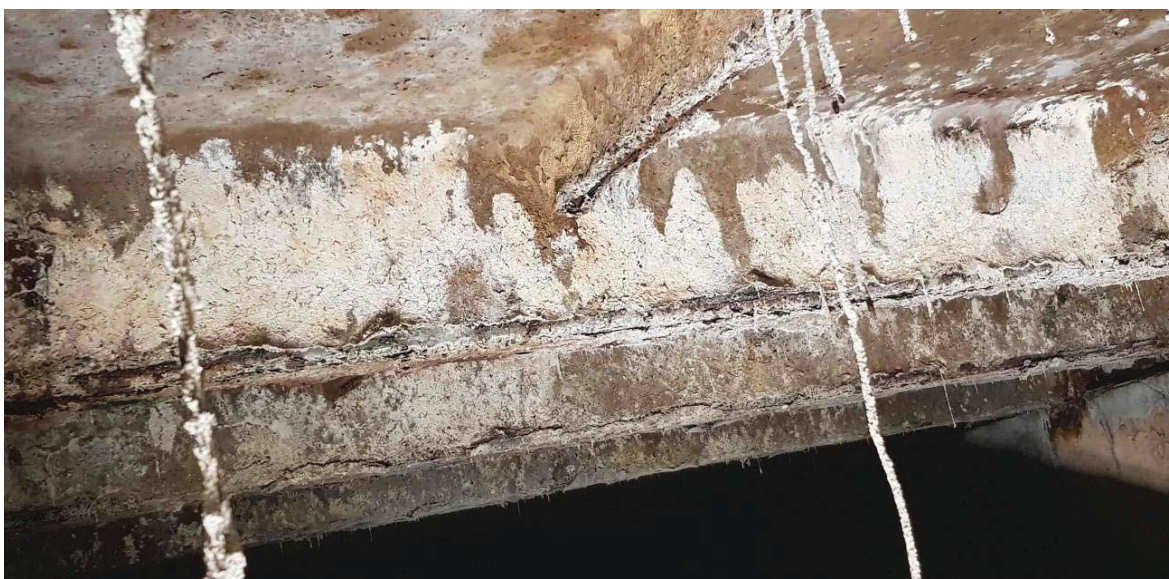
18 pav. Korozijos pažeista G/B perdanga
