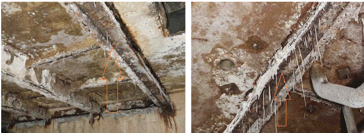
16,17 pav. Dvitėjinės metalinės sijos ir perdangos detalė
