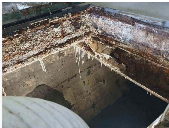
11,12 pav. Metalinių sijų korozija ties anga
