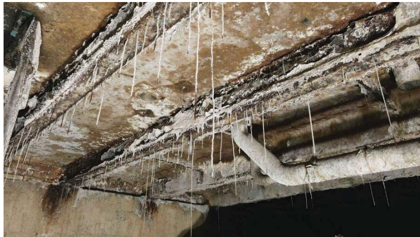
18 pav. bunkerio perdangos metalinių sijų pažaidos. Vaizdas iš apačios(bunkerio vidaus).
