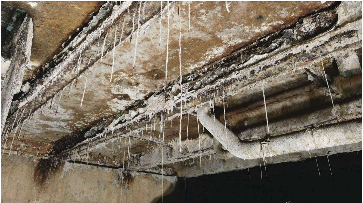
15 pav. bunkerio perdangos metalinių sijų pažaidos. Vaizdas iš apačios(bunkerio vidaus).
