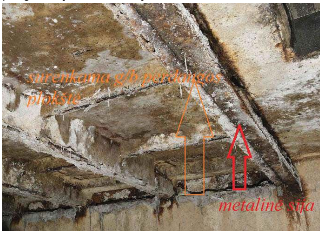
19,20 pav. Dvitėjinės metalinės sijos ir perdangos detalė
