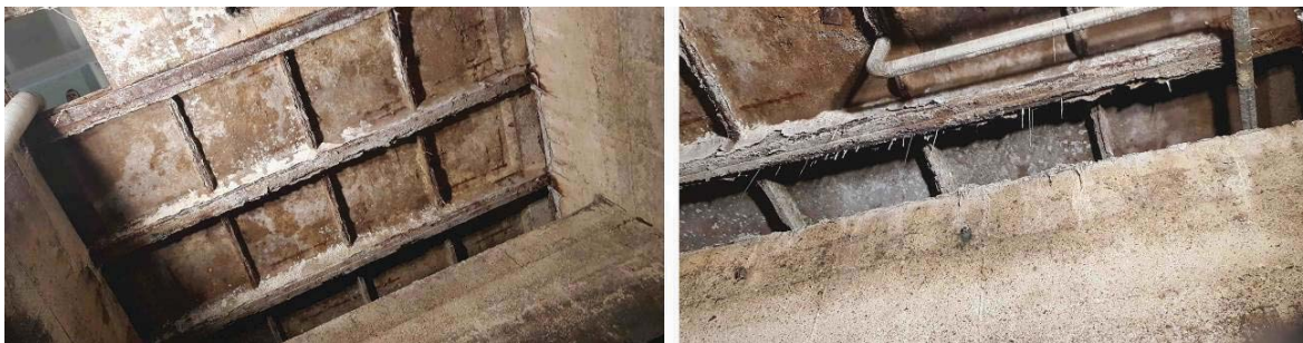
19,20 pav. Korozijos pažeista G/B perdanga
